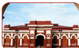
Estación del Ferrocarril, Granada.
