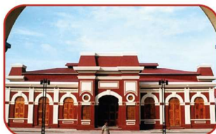
Estación del Ferrocarril, Granada.
